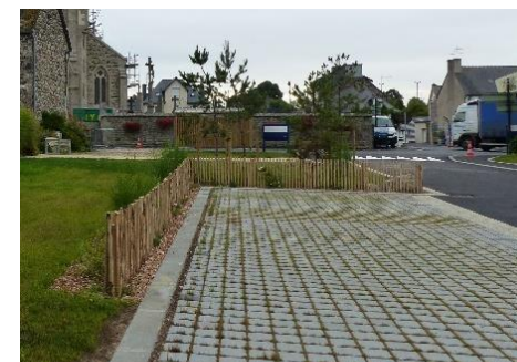
Stationnements en pavés à joints enherbés - Saint-Clet (22) Agence AGAP
